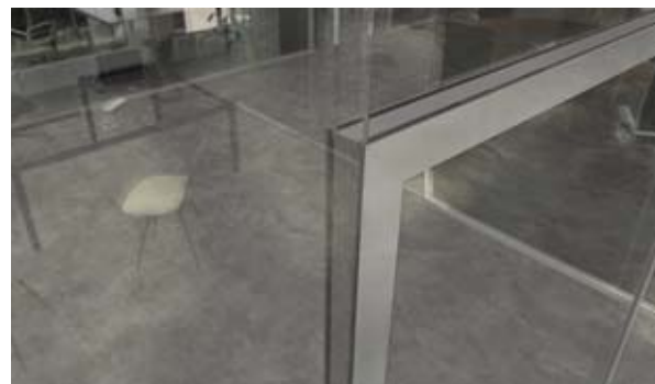
Huisserie incluse en cloison double vitrage.
