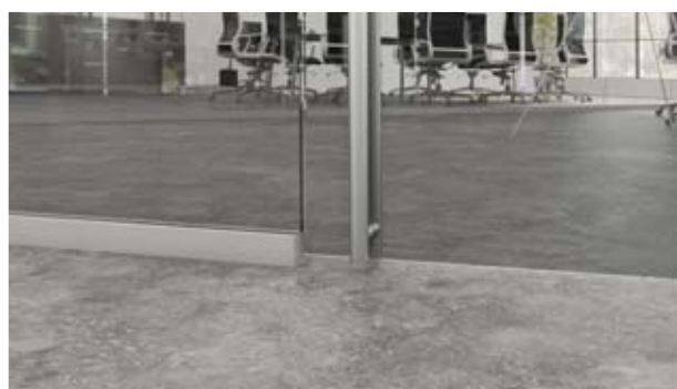
Porte verre sur cloison simple vitrage centré en finition verre libre.
