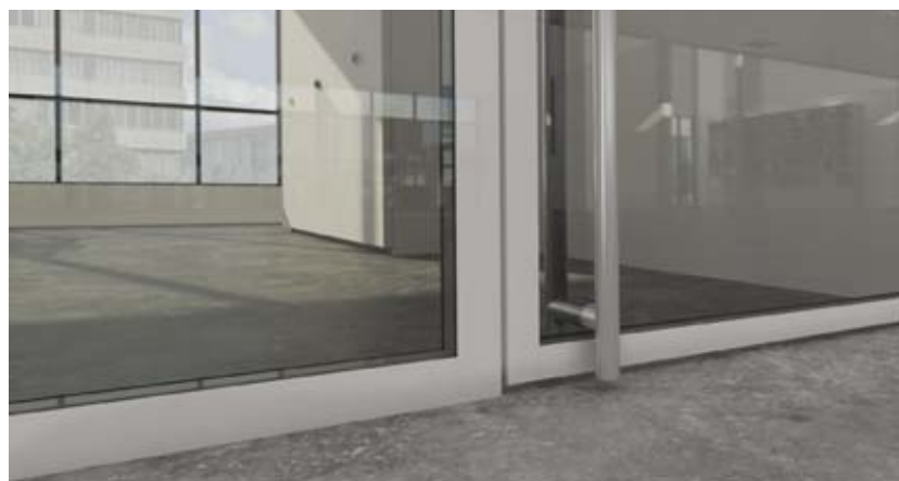
La traverse de porte s'aligne avec la lisse de la cloison.
