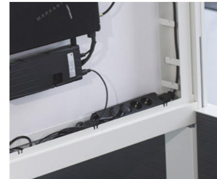
Stekkerblok in systeemwand
