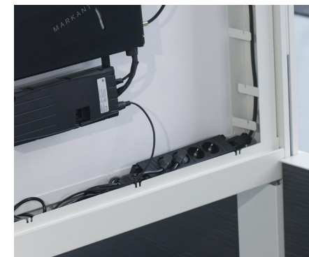
Stekkerblok in systeemwand
